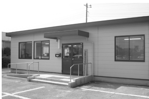
花園支所(花園総合支所敷地内)
